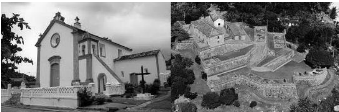
Figura 2. A esquerda igreja de N.S. das Necessidades e a direita o Forte de Santo Antônio (fonte: IHGSC, s.d. ).
